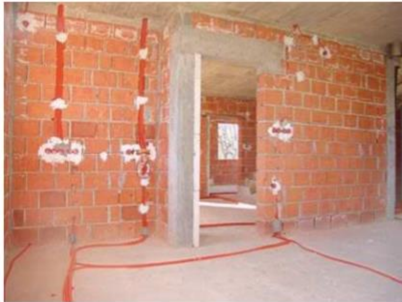
Talno-stenski razvod električne napeljave
